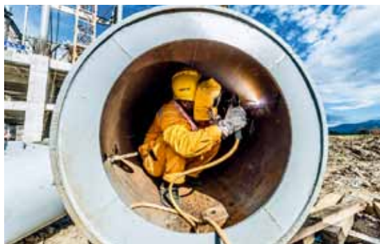
印尼北苏海螺一期项目
