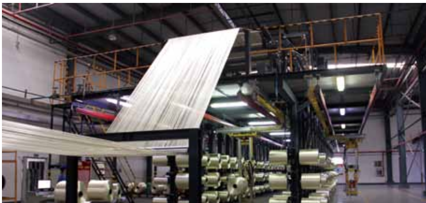
碳纤维原丝生产线
