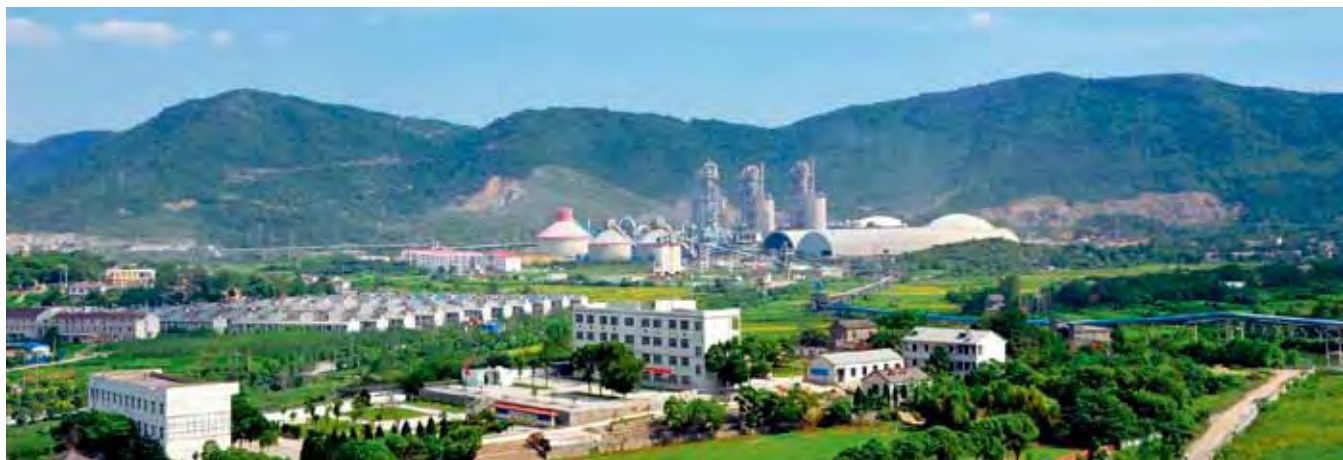
中材安徽水泥循环经济园远景
