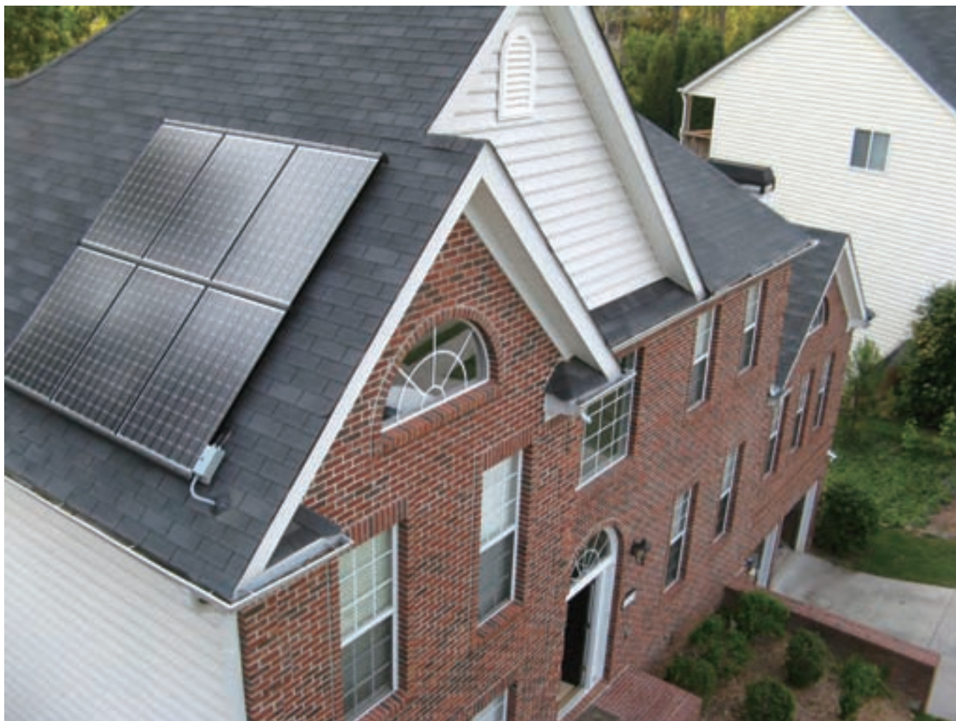
屋顶上的电磁板工程
