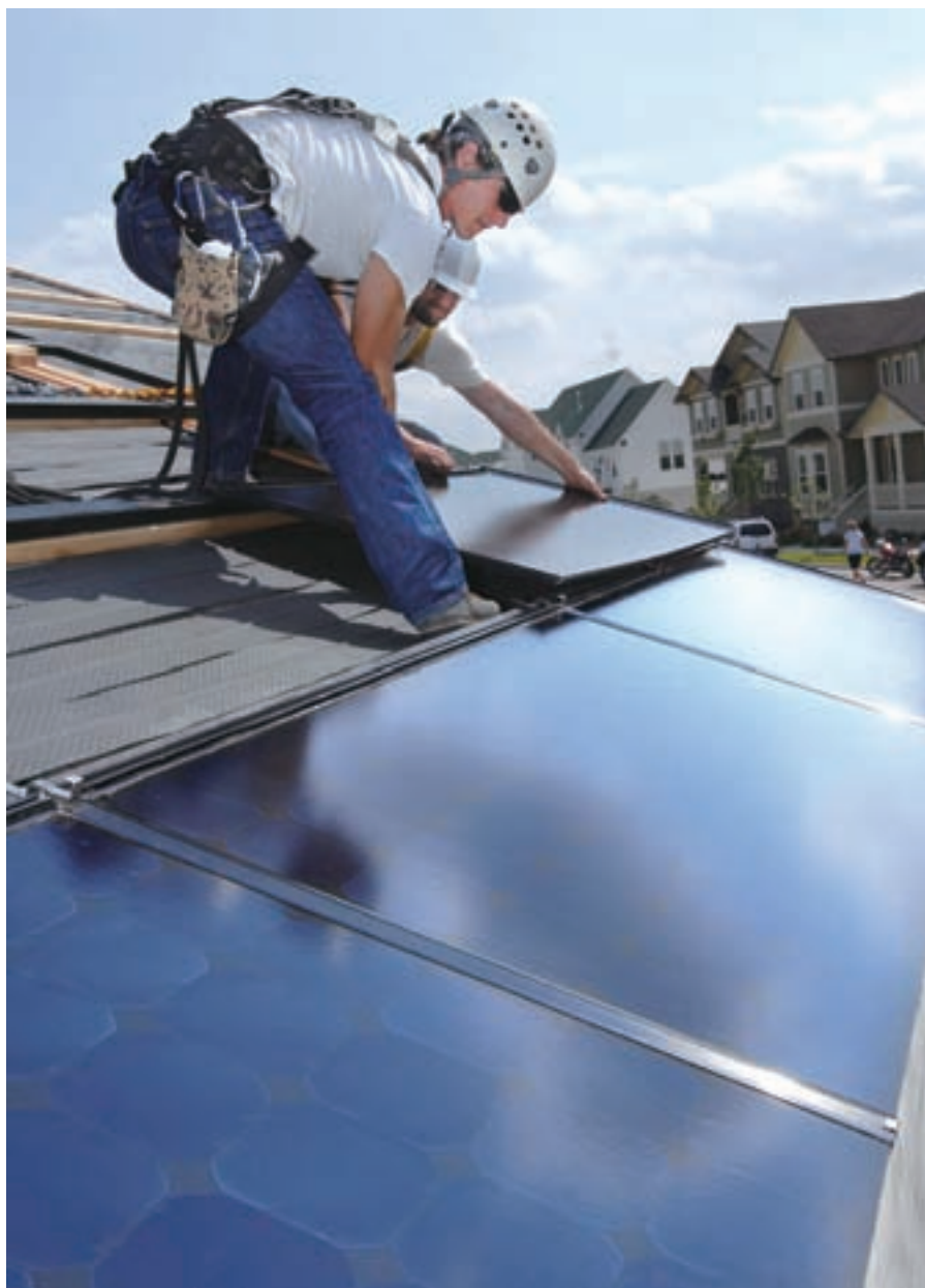
工人安装太阳能电磁板
