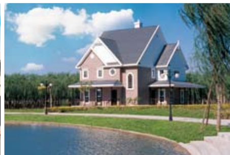
中国建材集团天津新型住宅示范区
