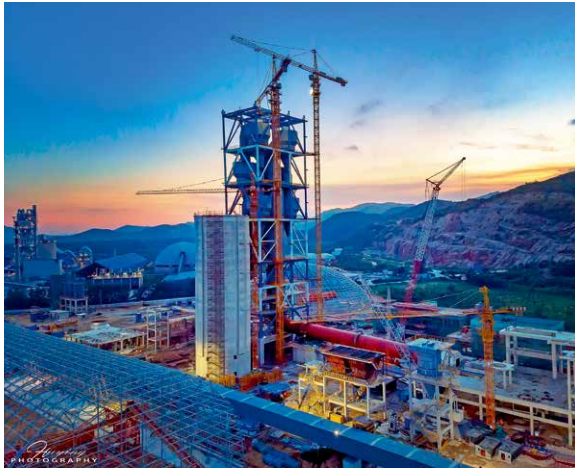
建设中的湖州槐坎南方水泥
