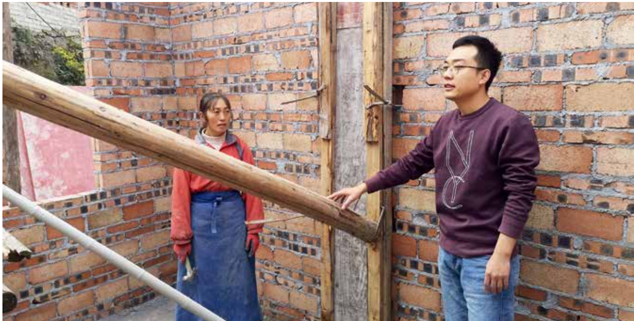
查看安全房建设情况
