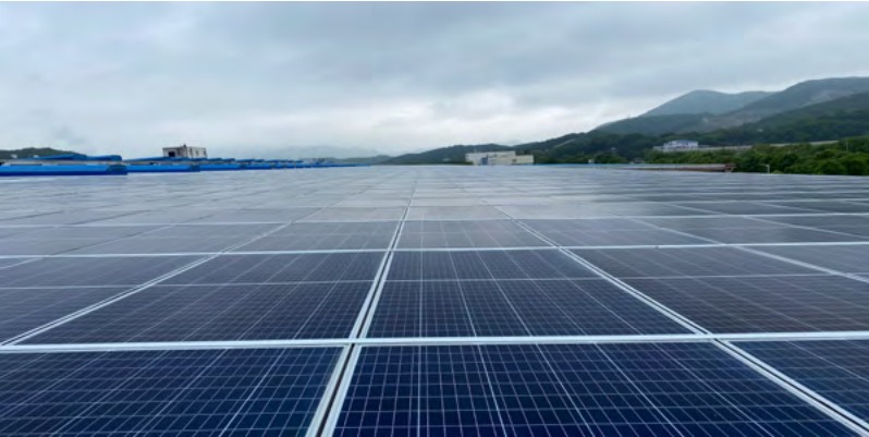
宁波北新光伏工厂
