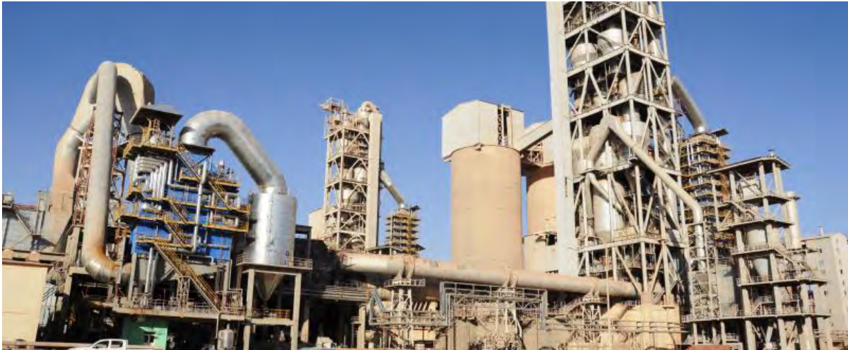
沙特 YCC 余热发电项目
