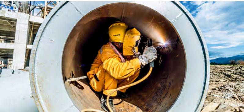
印尼北苏海螺一期项目现场
